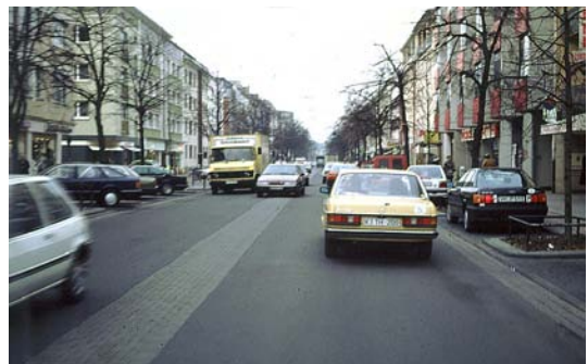
Bild 4.19: ...auf zweistreifigen plus Mittelstreifen zurückgebaut
