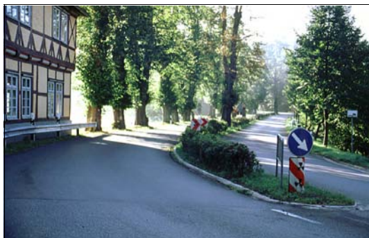
Bild 4.32: Mittelinseln in Kurvenlage bieten die beste Geschwindigkeitsreduzierung
