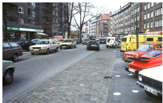
Bild 4.16: Mehrzweckstreifen als Ausweichfläche und zur Abwicklung des Lieferverkehrs
