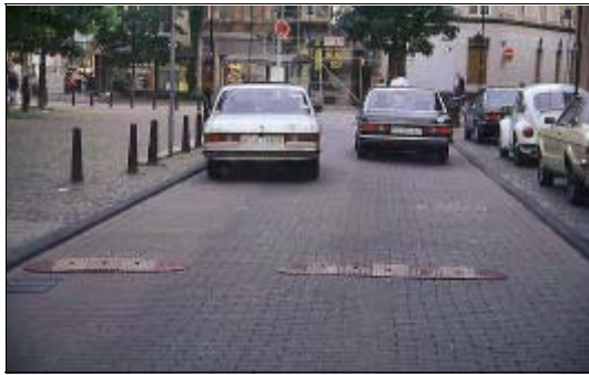
Bild 3.18: Stark dämpfende Metallschwelle
