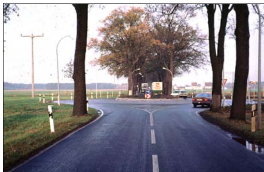
Bild 4.33: Gut in eine Baumalle eingepaßter Kreisverkehrsplatz
