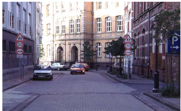
Bild 4.8: Aus Lärmgründen sinnvoller Einsatz von Betonsteinpflaster
