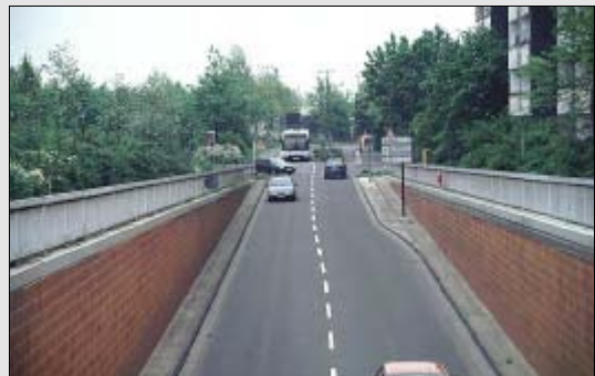
Bild 3.15: Straßenumbau im tiefliegenden Abschnitt
