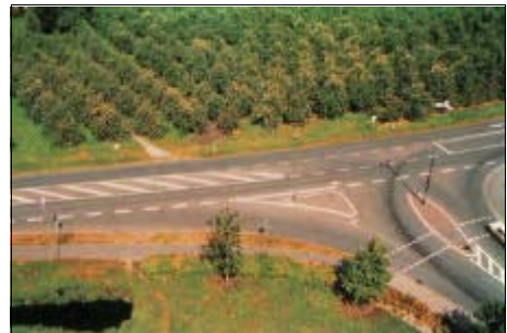
Bild 3.27: Situation vor Umbau
