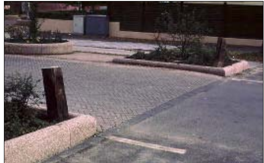
Bild 3.20: Aufpflasterung mit mittlerer Rampensteilheit
