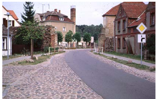
4.38: Gut eingepaßter Kompromiß zwischen Gestaltungsanforderung und Lärminderung
