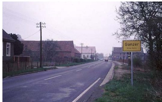
Bild 4.31: Kurze, "überschaubare" Ortsdurchfahrten veranlassen Kraftfahrer kaum, die Geschwindigkeit stark zurückzunehmen
