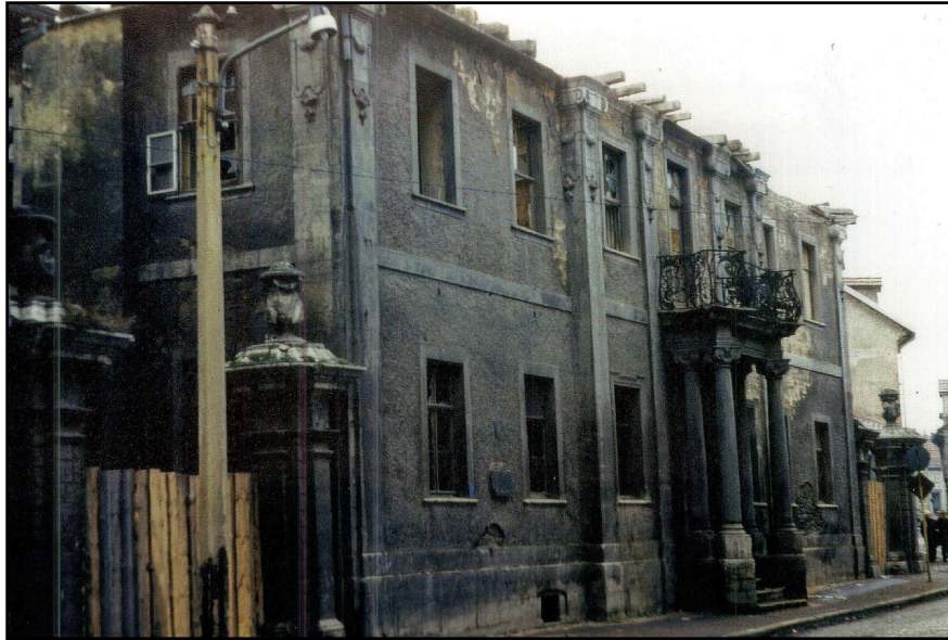
Zustand nach Abnahme Dach 1976
